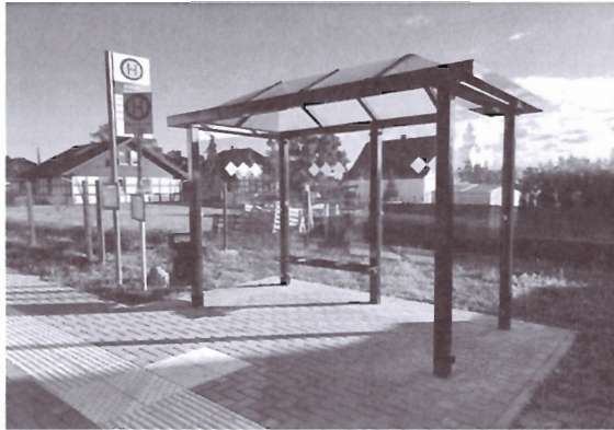
Das nenne ich service. Die neue Bushaltestelle ist standartüblich aufgebaut.
