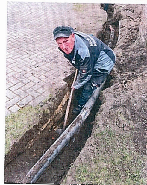
Eine alte Rohrleitung wird freigelegt.
