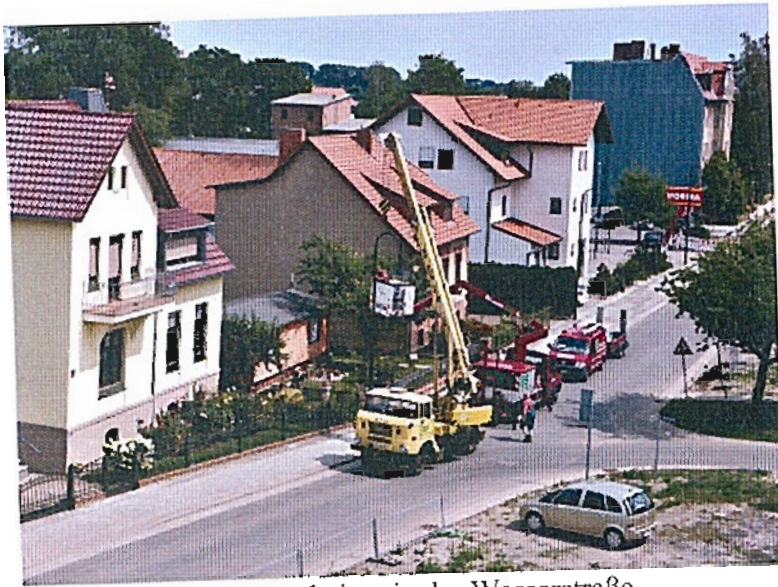
Sanierungsarbeiten in der Wasserstraße.
