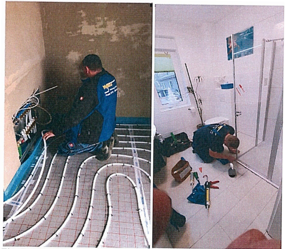
Eine Fußbodenheizung wird gelegt. Eine Duschkabine wird aufgestellt.
