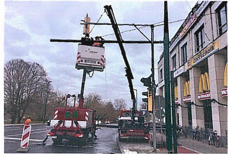
Eine Ampelanlage wird montiert. Zwei Steigerfahrzeuge im Einsatz.
