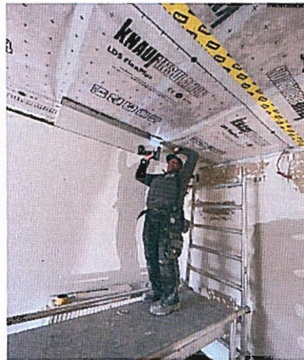
Trockenbauarbeiten
