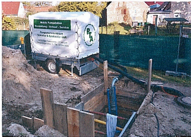
Ein Pumpensystem wird in einem Schacht verlegt.
