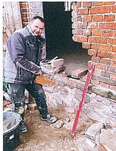
Ein alter Bau wird saniert.
