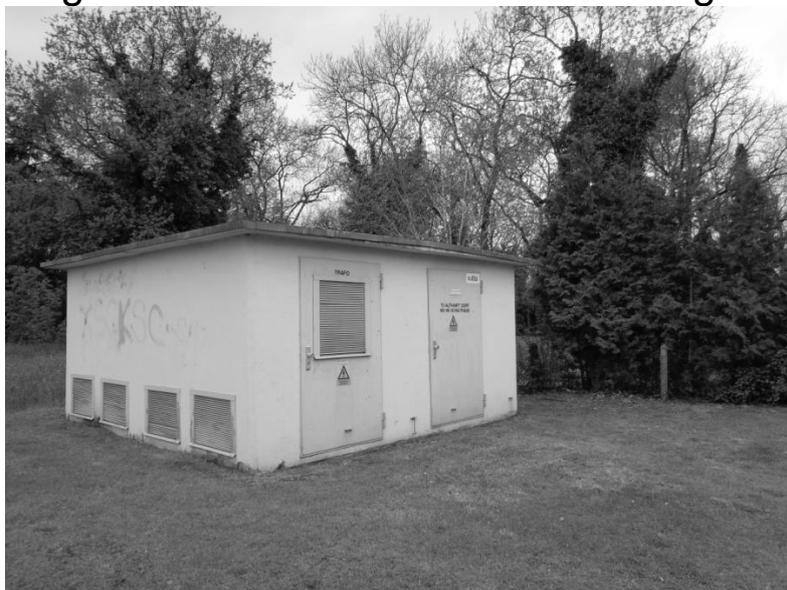
Der Hochtrafo wurde durch einen Flachbau ersetzt.
