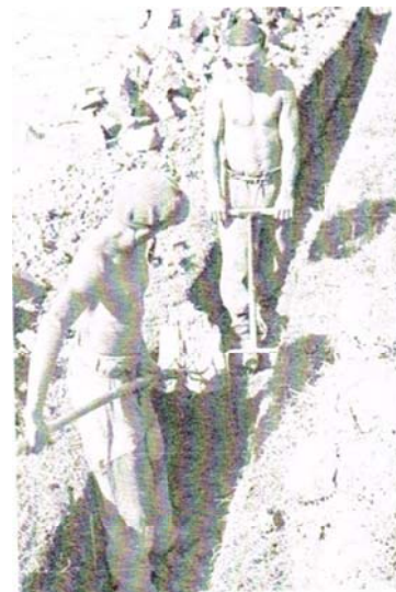
Die Gräben für die Drainagerohre wurden
