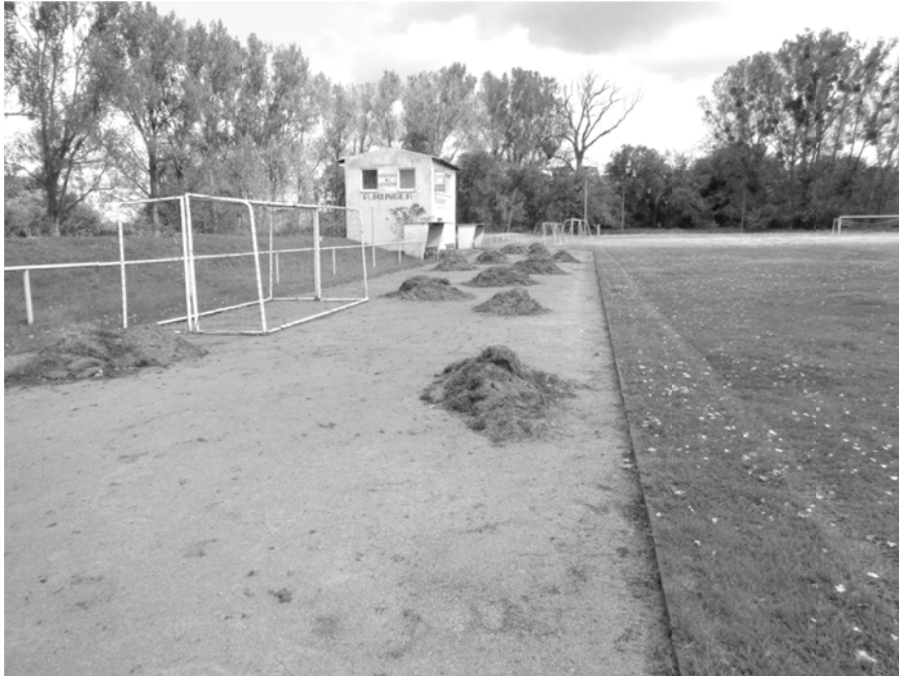
An der Sanierung der Aschenbahn wird gearbeitet.
