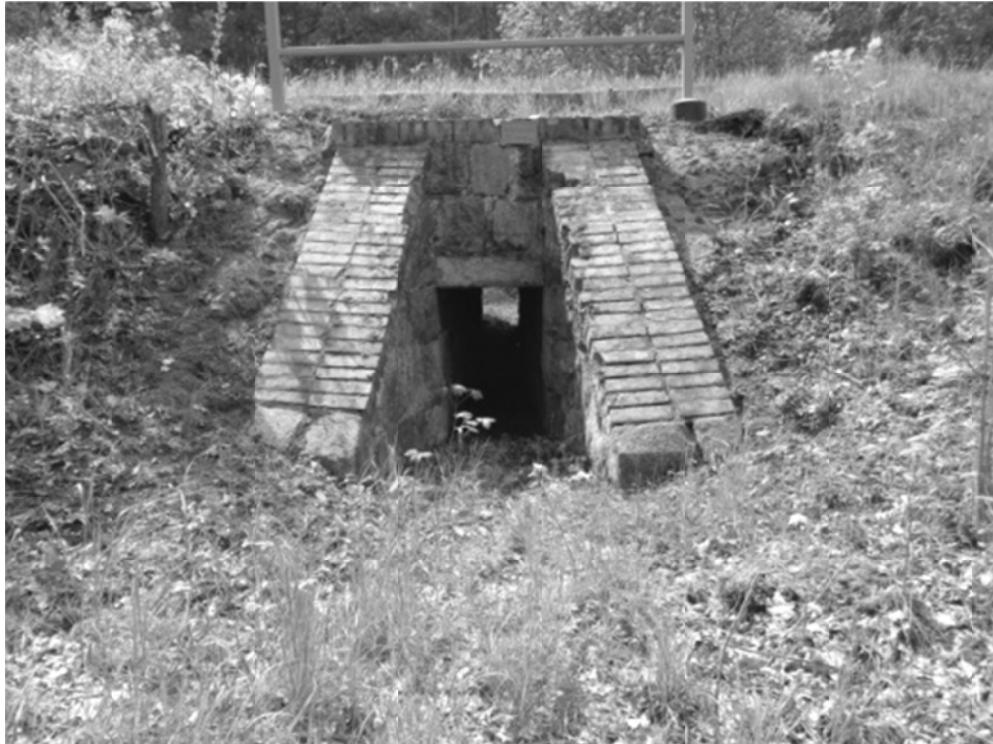
Der Durchlass vor dem Bahnübergang nach Bad Freienwalde.
