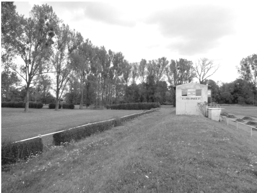
Der Kampfrichterturm wird zurzeit bei Reitsportveranstaltungen genutzt.
