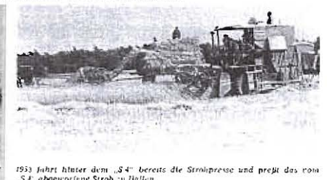
1953 fuhr Huster dem „S4“ bereits die Strohpresse und preßt das vom „S4“ abgeworfene Stroh zu Ballen
