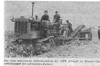
Die erste schweizerische Zellenkombi der MTS Altranft im Einsatz (Spezialschlepper mit schmaleren Ketten)
