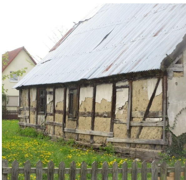
Abbildung 9 Am Anger 20, Lehmfachwerk, Seitenansicht Foto: Lisa Herzog, 20.04.2018
