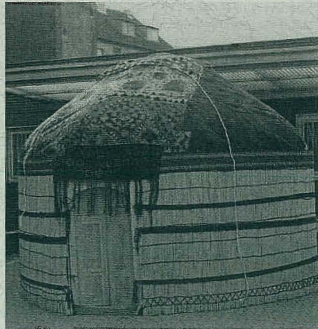
Abb.: Afghanische Jurte, Durchmesser 4,45 m, Wandoöhe 1,90 m, Innehöhe der Kuppelmitte 3,40 m
